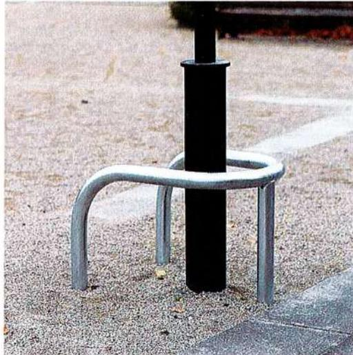
*Exemple de butée acier pour protection des poteaux*
